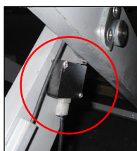
Верхний концевой выключатель
