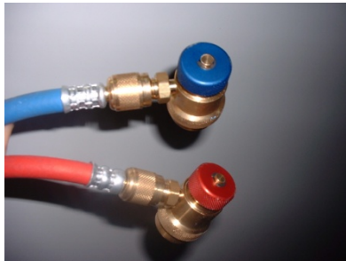
Зображення 9 а – Швидкоз'єднувальні муфти високого та низького тиску
